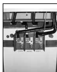
Utility lug landing
