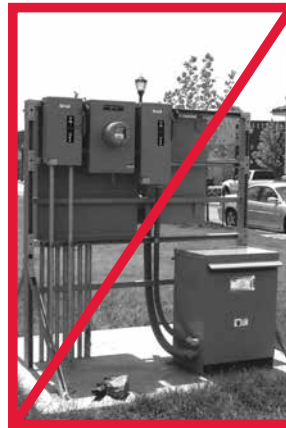
Puntal y tablero
